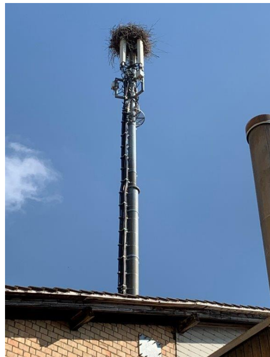
20m Mast mit seitlicher Fixierung an Backsteingebäude
